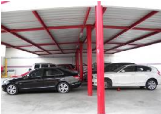
Estacionamiento autos en proceso
